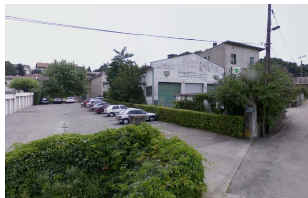
Périmètre d'étude OAP Revériaz – Boulevard Henri Bordeaux (à gauche) Rue de La Revériaz (à droite) / Citadia Conseil
