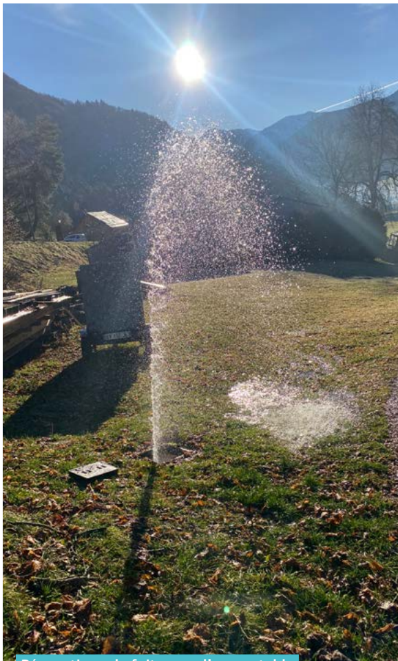
Réparations de fuites sur l'eau potable
