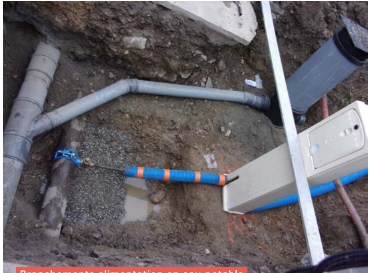
Branchements alimentation en eau potable et raccordement au réseau d'eaux usées
