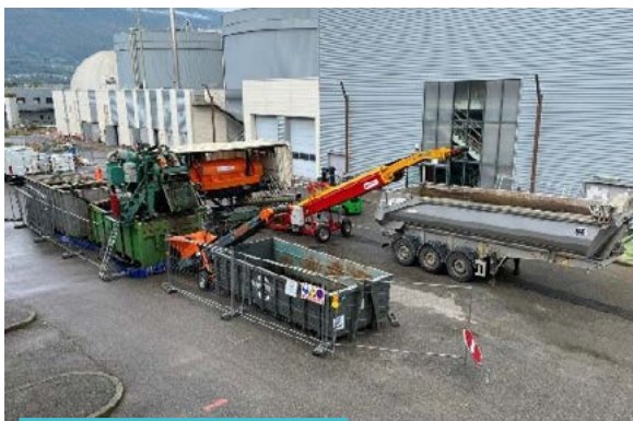
Maintenance des digesteurs
