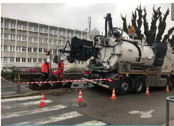
Maintenance préventive siphon pont des Carmes
