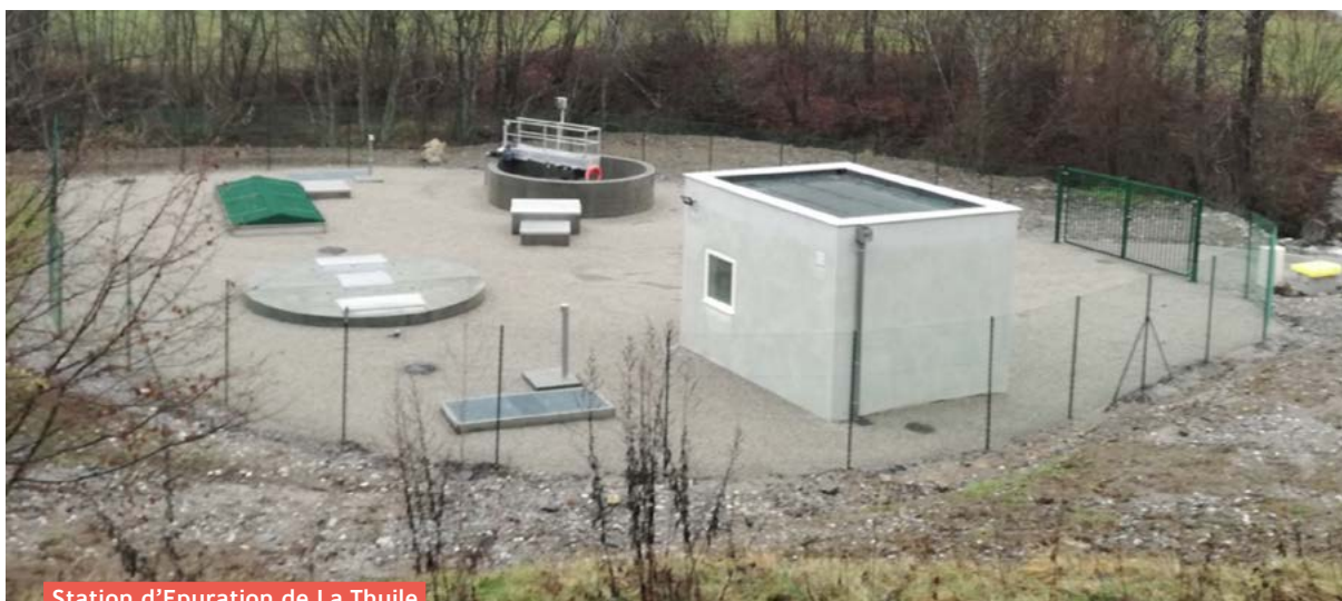
Station d'Épuration de La Thuile
