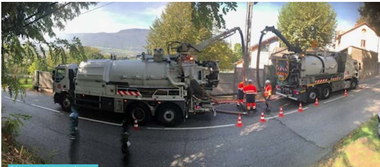
Réparations casse réseaux
