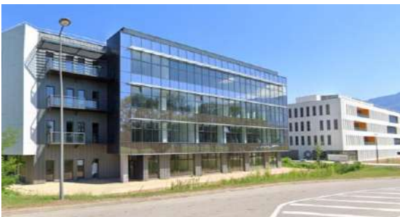
Bâtiments en limite Savoie Technolac / secteur d'étude
