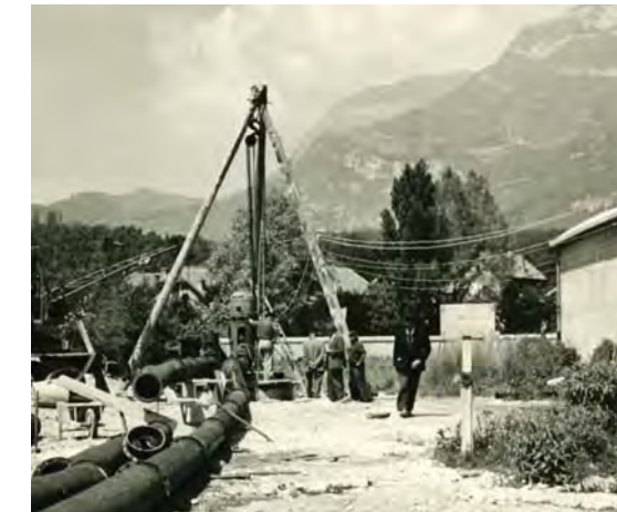
1957 Construction du puits Joppet à Chambéry : essai de pompage
