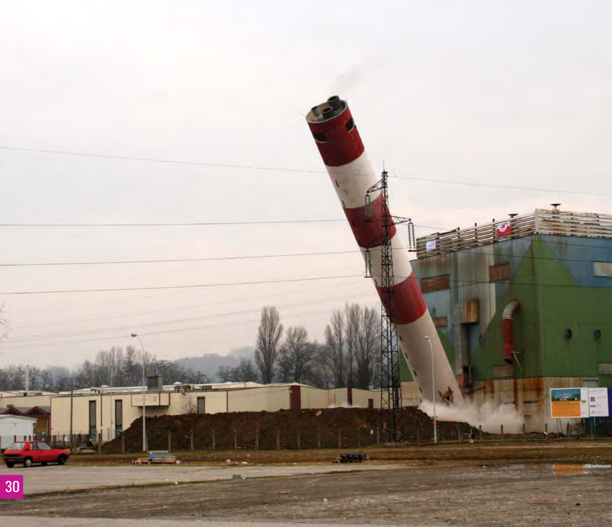
2006 Usine d'incinération : début des travaux, chute de la cheminée
