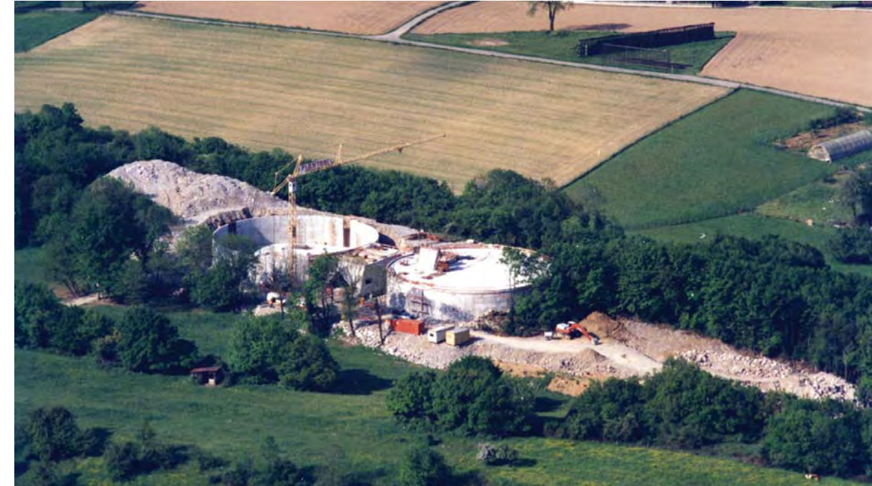
1995 Construction des réservoirs de Saint-Jeoire-Prieuré.
